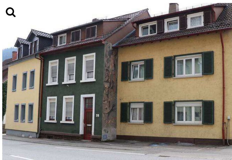
Das Gebäude in der Neckarstraße 39, am Brückenkopf des Kreisels, soll einer Wohnanlage mit insgesamt 19 Wohneinheiten weichen. Foto: Bayer
